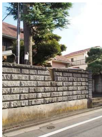
一部に切り欠きのある大谷石の塀
