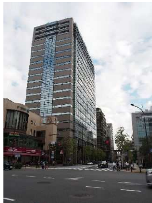
日本橋浜町Fタワービル 浜町地区の最初の大規模再開発
