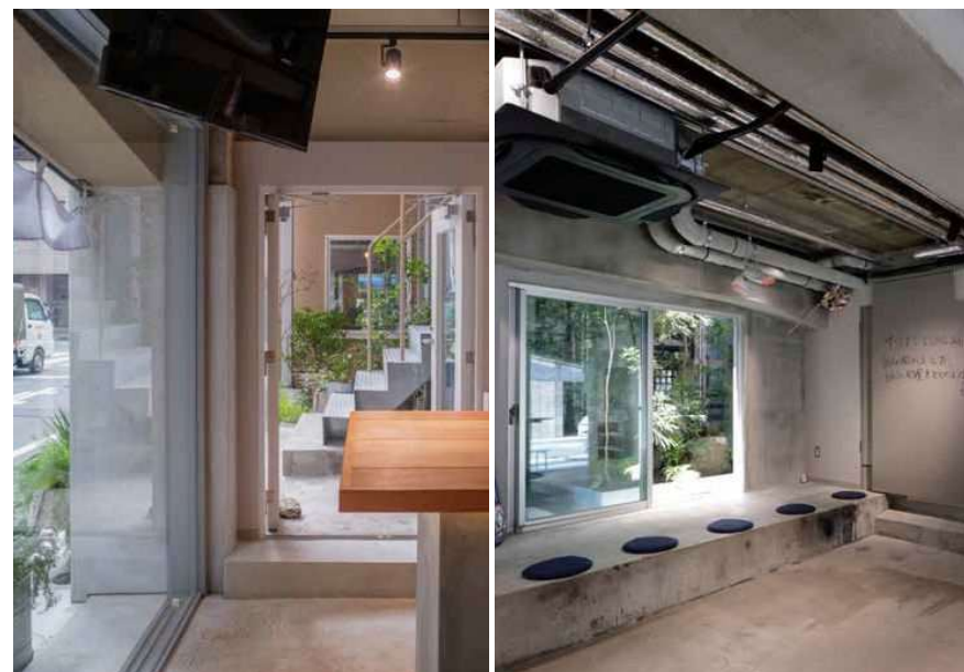
左：鉄筋コンクリート造ラウンジより増築部ピロティを見る。壁を抜いた分、柱巻き補強を行った。／右：鉄筋コンクリート造ラウンジより庭越しにT-HOUSE（本誌2010）を見る。T-HOUSEも安田不動産による日本橋浜町の一連の再開発。*
