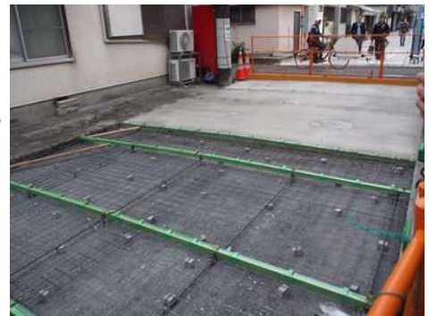
住吉稲荷前の舗装工事
