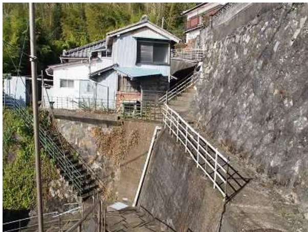
階段が巨大迷路のように巡っている
