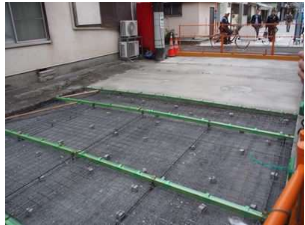
住吉稲荷に突き当たる路地、舗装工事
