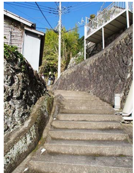
階段から見えるのは階段と擁壁
