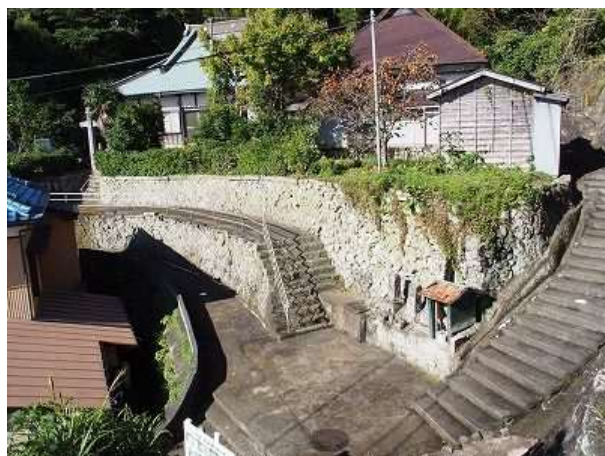
旭洞院とその擁壁
