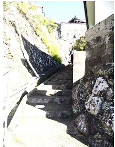
階段、擁壁、塀が重層して景観を形成している。
